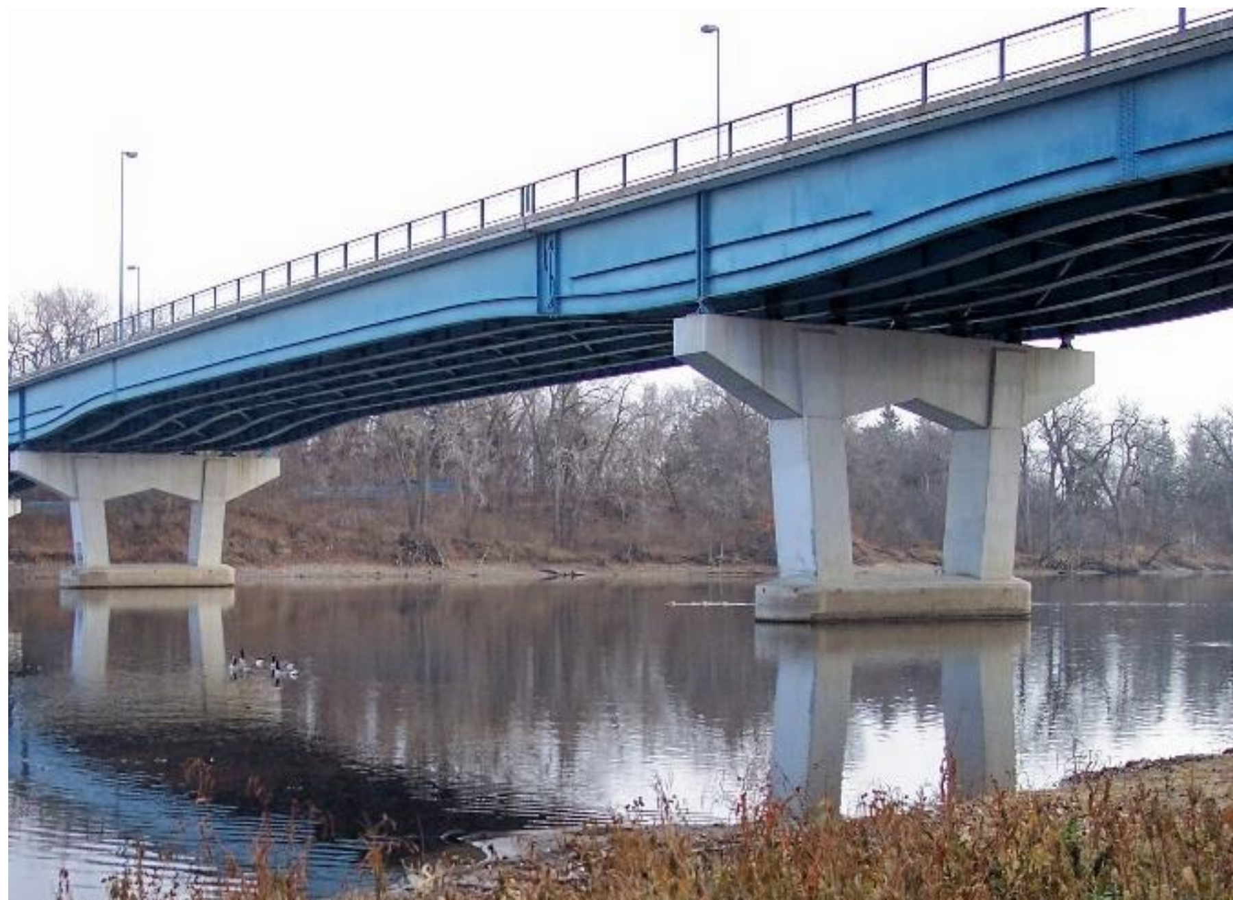
Poutres d'acier ou de béton
