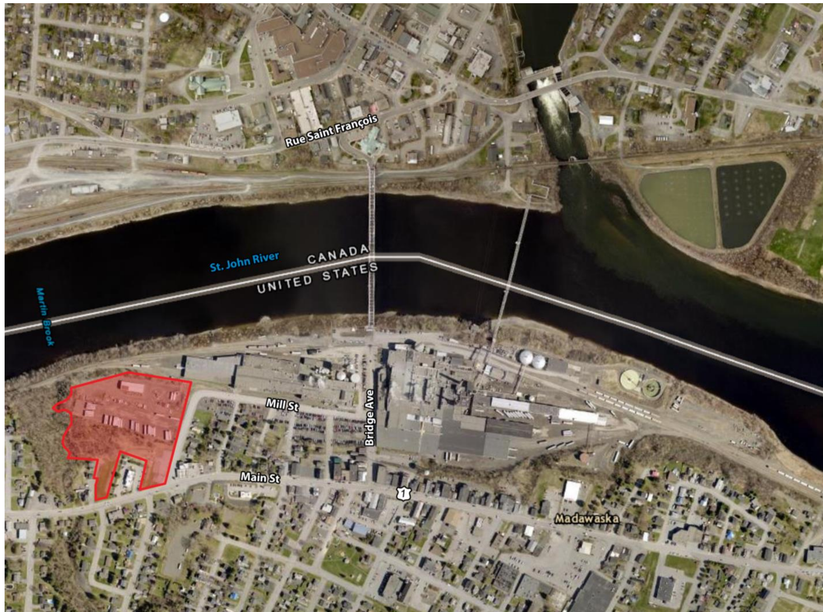
Pont international et poste frontalier de Madawaska-Edmundston
